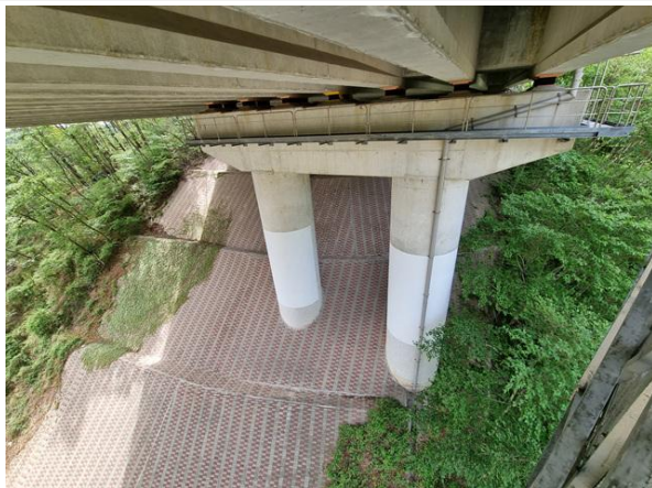
교각 P1 기초 전경
