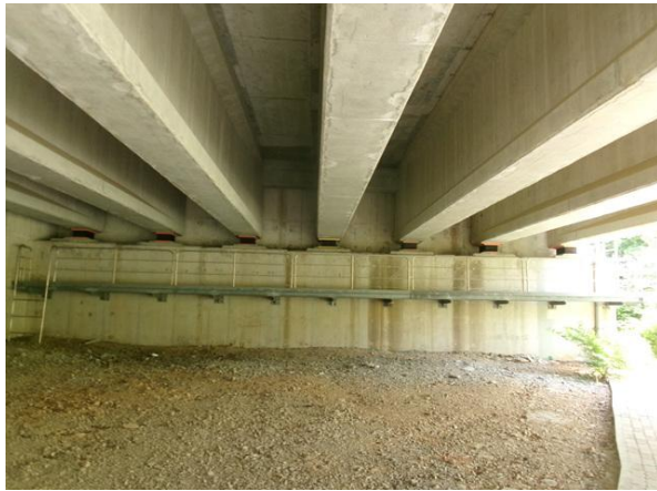
교대 A1 기초 전경
