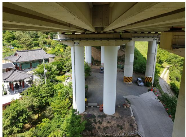
교각 P6~7 기초 전경
