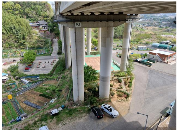
교각 P2~3 기초 전경
