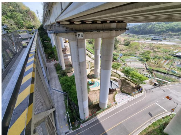
교각 P4~5 기초 전경
