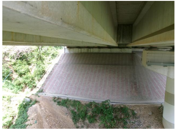
교대 A2 기초 전경
